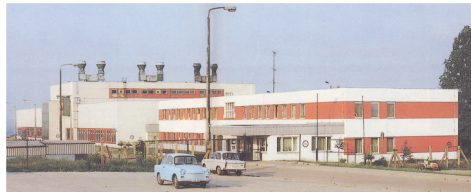
Apolda neues Drehteilwerk
